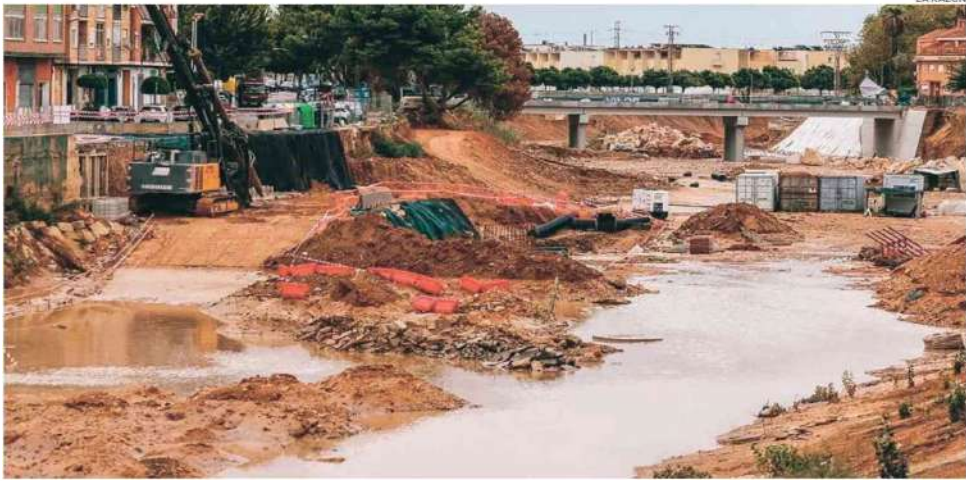
Imagen del barranco a su paso por Aldaia, una de las poblaciones más dañadas por la dana
