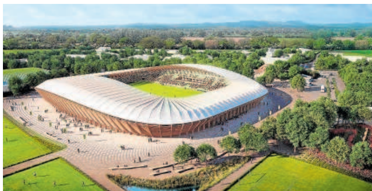
El futuro estadio del Forest Green Rovers estará construido en madera // FOREST GREEN ROVERS
